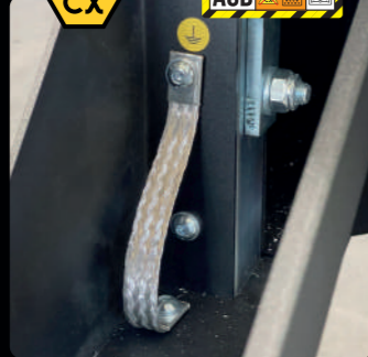
TUTTI I COMPONENTI SONO MESSI A TERRA
